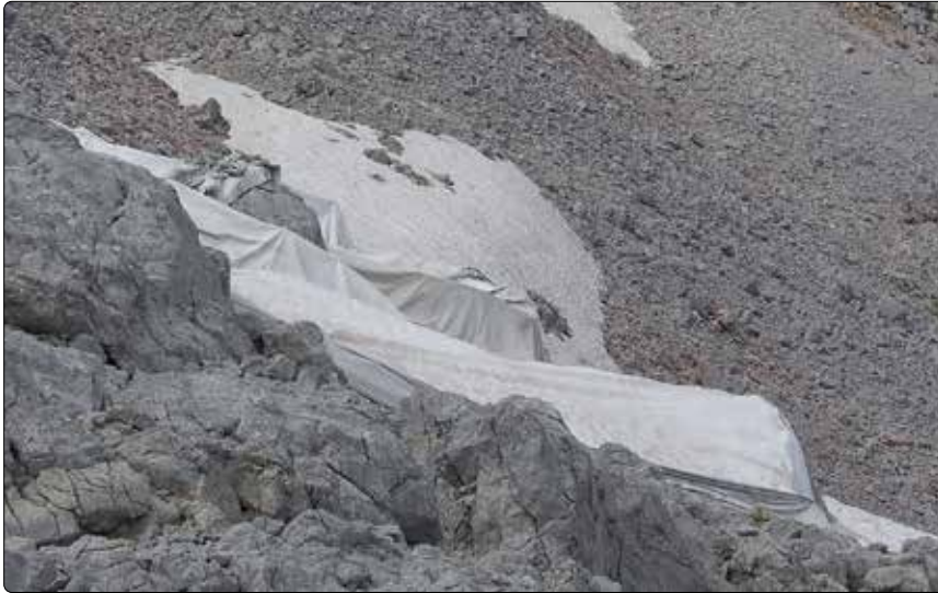
Am Ingolstädter Haus im Steinernen Meer werden die Altschneefelder, die die Hütte mit Wasser versorgen, mit weißen Planen überdeckt, die die Schmelzgeschwindigkeit reduzieren.
